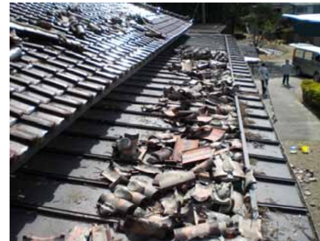
※瓦が落ちてトタン屋根に穴が!!
