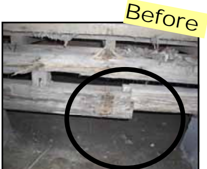
腐朽部分の土台を入れ替え、床下の防湿作業や防蟻剤塗布も完了
