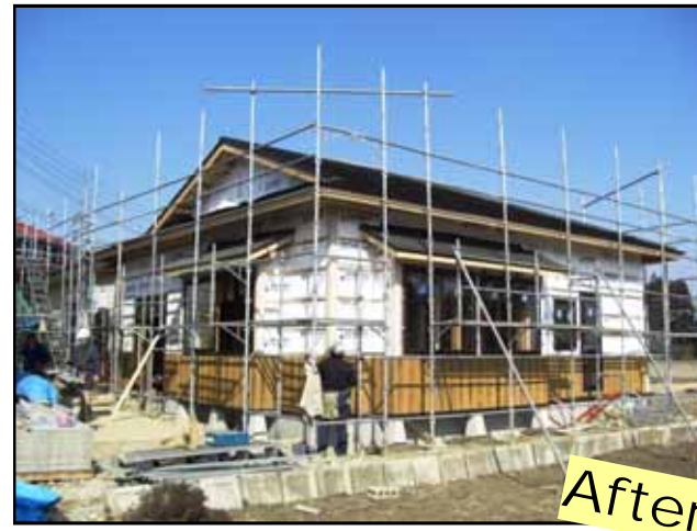
腰壁張り完了(3/18現在)
