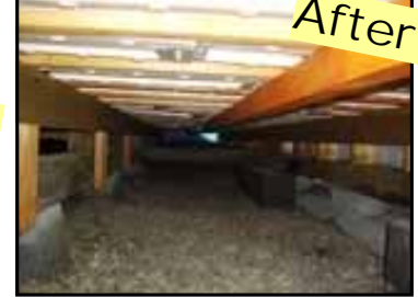
腐朽部分の土台を入れ替え、床下の防湿作業や防蟻剤塗布も完了
