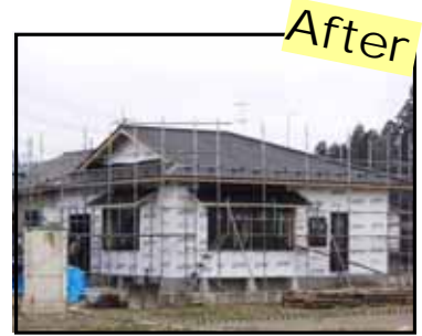
外壁下地の通気シート張り完了
