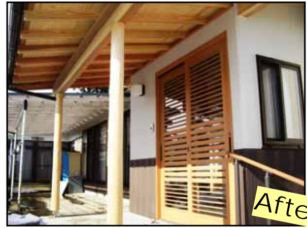
基礎から全面耐震補強外壁と断熱サッシの入替で暖かい家の誕生
