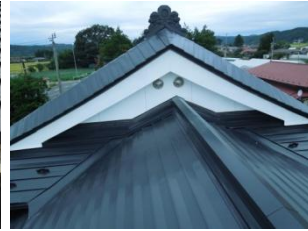
⑥瓦屋根の形状にあわせて鋼板を敷いていきます
