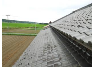
⑥瓦屋根の形状にあわせて鋼板を敷いていきます
