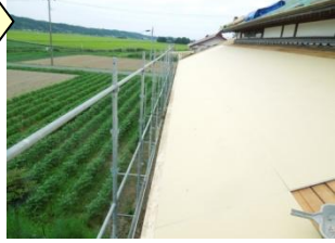
④石膏ボードで屋根の遮熱・遮音工事
