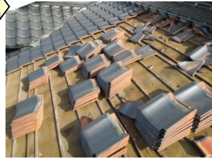
②既存の瓦おろし作業
