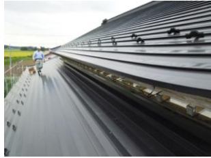
⑥瓦屋根の形状にあわせて鋼板を敷いていきます
