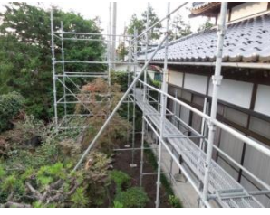
①安全のため足場を架設します
