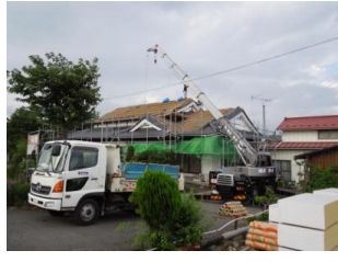
④石膏ボードで屋根の遮熱・遮音工事
