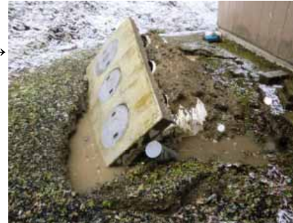
地盤沈下 土留め擁壁崩れる
