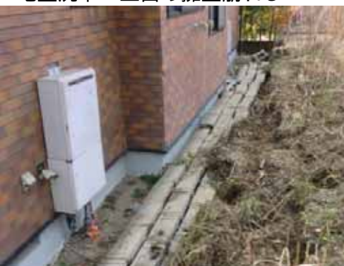
地盤沈下 土留め擁壁崩れる
