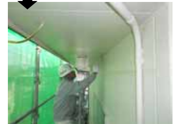
外壁軒裏天井改修
