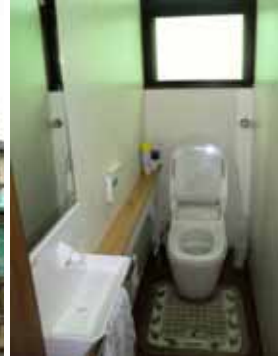
トイレ下水切替改修
