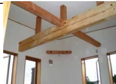
子供部屋8畳の勾配天井
