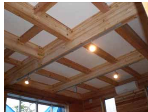
LDKの梁現し天井
