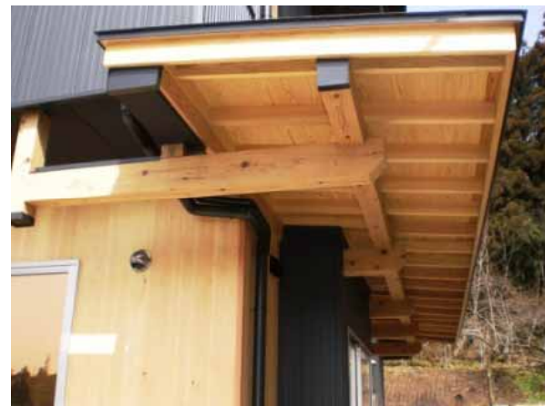
東面の柱なしの1.6m出の庇
